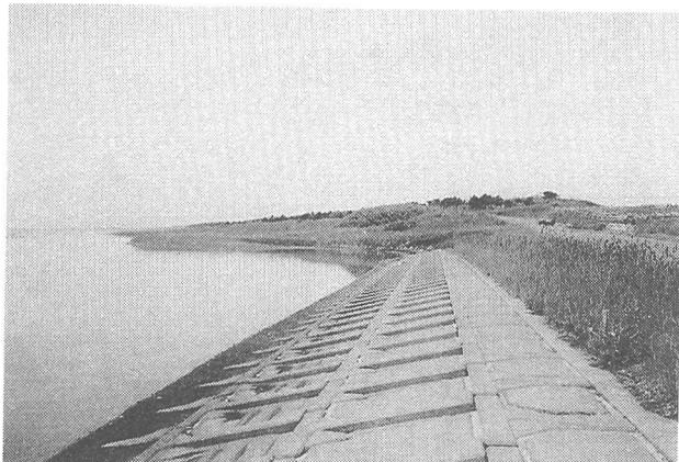
写真-12 コンクリート護岸で覆われた湖岸
