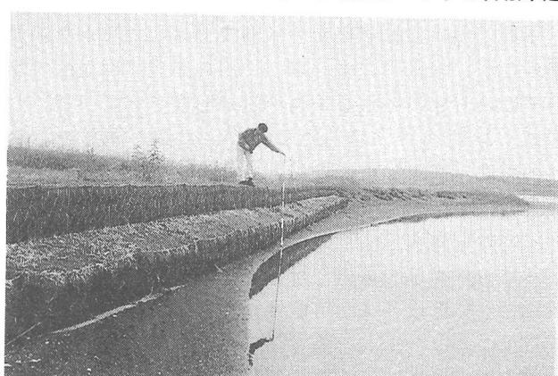
写真-13 写真-11の東側隣接域で、侵食が進んだため新たに設置された蛇かご式護岸
