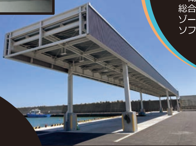
中の川漁港 天蓋施設
