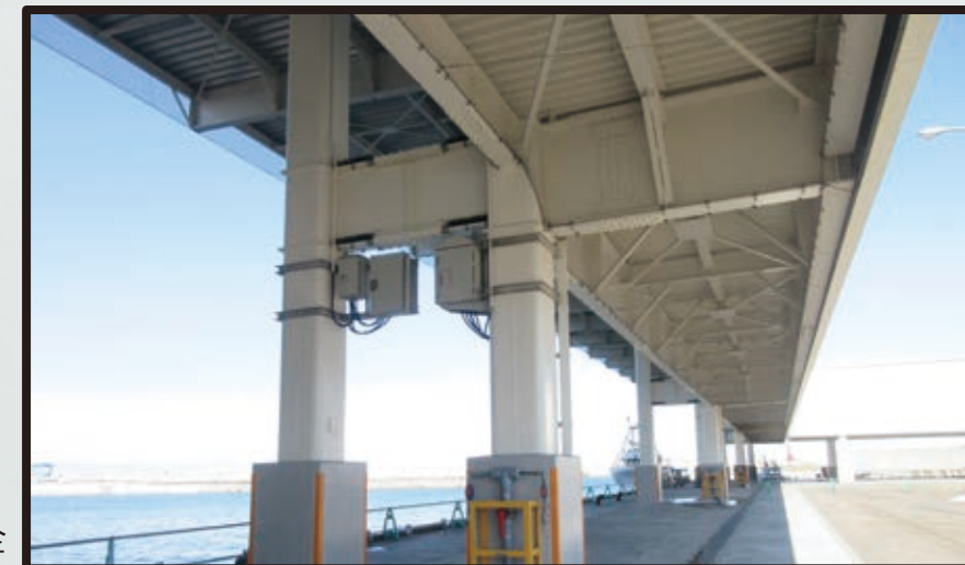
常呂漁港 天蓋施設 機能保全
