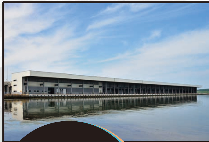
厚岸漁港 人工地盤+屋根施設
